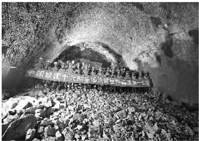
4月15日,中铁建十六局员工在青藏铁路新关角隧道全线贯通后庆祝。当日16时,随着青藏高原东北缘关角山深处响起两声炮响,由中国中铁隧道集团和中国铁建十六局集团共同庆祝近7年的世界最长高原铁路隧道——青藏铁路新关角隧道双线正洞全线贯通。
