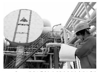
国产2.5万吨大型海水淡化装置前记录设备运行情况。该 装置去年在河北省沧州市安装试运行,目前进入稳定生产 期,各项指标正常。 傅新春摄(新华社发)
