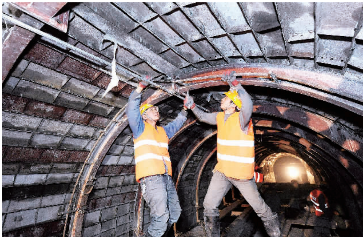
图为4月10日，中铁隧道集团工人正在关角隧道紧张施工，关角隧道地处青藏高原东北缘。历时近7年施工，全长32.645千米，国内在建特长隧道，世界高海拔铁路第一长隧——关角隧道即将全线贯通。 本报记者 赵晶摄
