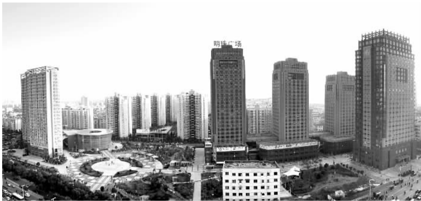
图为青云谱区的南昌明珠广场。该广场在江西拖拉机制造厂原址上拔地而起，目前已吸引300多家公司入驻。 赵岩摄
