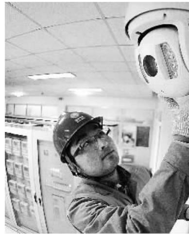
由国家电网公司承建的智能电网应用关键技术研究示范工程——电力IPv6实验网络近日建成,图为工程技术人员在检查基于IPv6的网络视频设备。 新华社发
