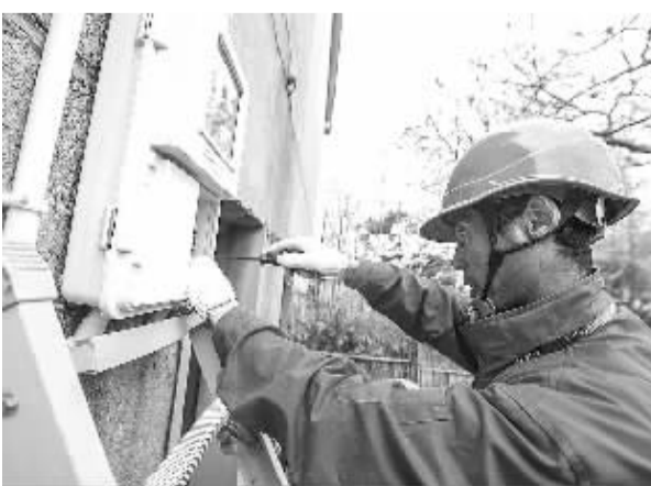
为避免家用电器功率大导致的火灾事故，浙江省长兴县政府联合供电公司等部门开展全县农村家用电流保护器安装全覆盖工程，预计今年将完成全县10多万户农户的家用电流保护器安装、升级工作。图为工作人员为煤山乡农户安装电流保护器。新华社记者 徐显摄
