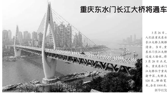
人们在重庆东水门 长江大桥上做桥面 清洁。当日,重庆 东水门长江大桥通 过竣工验收,将于 3月28日正式通 车。重庆东水门长 江大桥位于重庆市 渝中区,大桥主跨 520米,桥面宽21 米,全长1000米。
