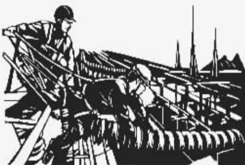
变电站里高压危
