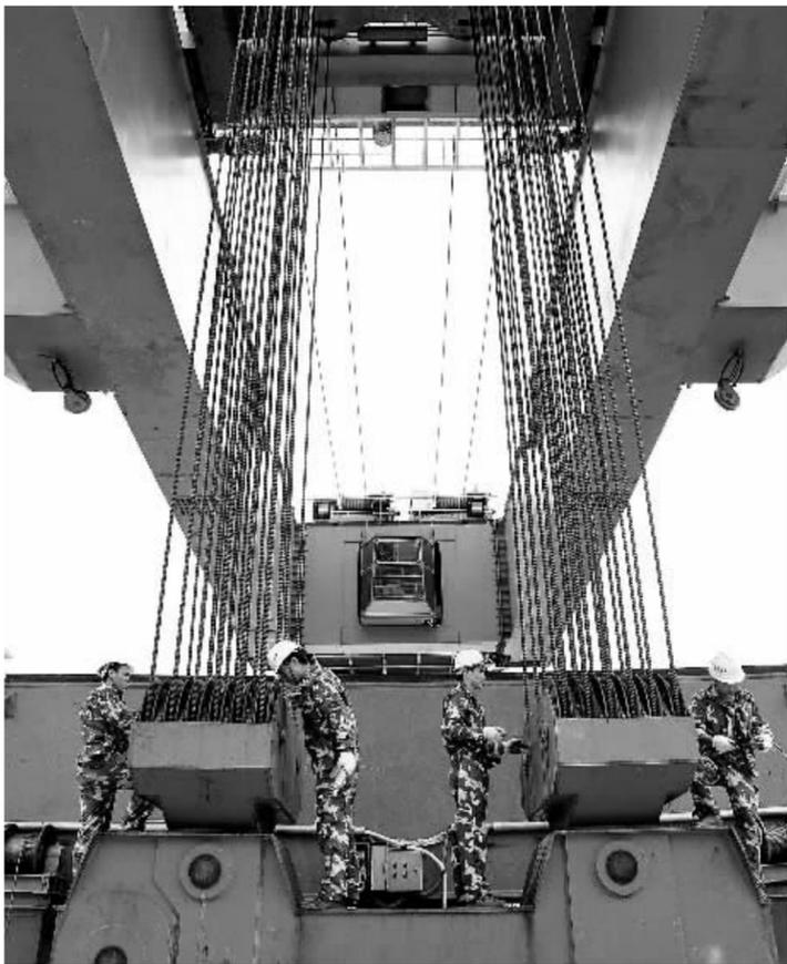
型运梁车和架梁机，经过反复实验、反复操作，终于掌握了这一先进技术。在施工中，他们充分发挥连续作战的精神，坚持“两班倒”作业，克服了设备庞大不易操作、桥梁变高、变跨技术难度大、重复作业人员容易疲劳等困难，实现了日架预制梁6片的纪录，达到同行业内最高水平。
