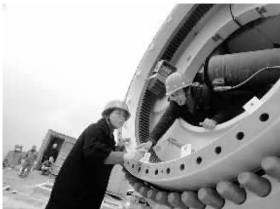
陈丽华在施工现场。
