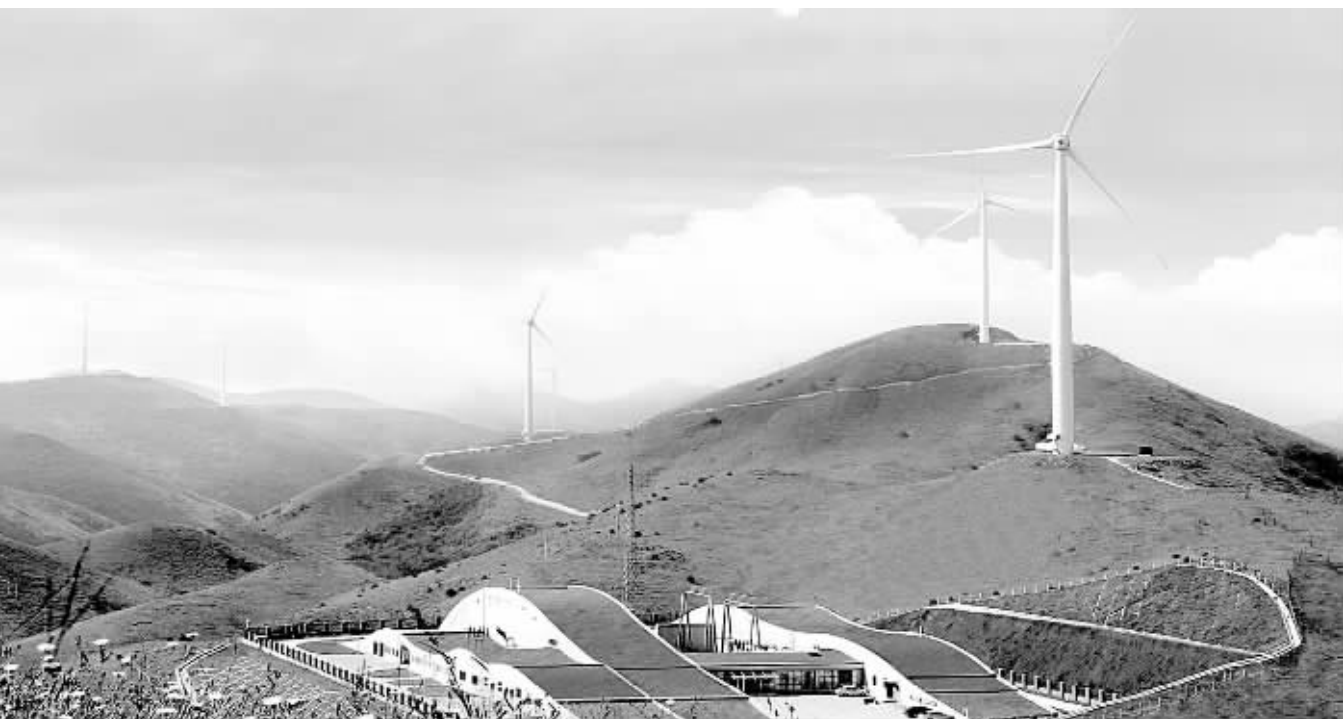
大唐华银城步新能源公司南山风电场升压站全景。
