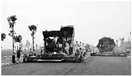
目前,渭河全线堤防工程主体已经完成,堤顶道路铺装完成204公里,堤防绿化完成215公里。
