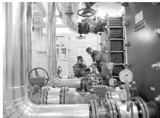
中国石化新星石油公司的工作人员正在开发利用地热资源。
