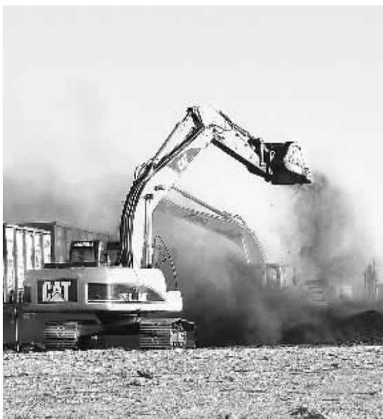
珲春铁路口岸装卸车在运煤炭。
