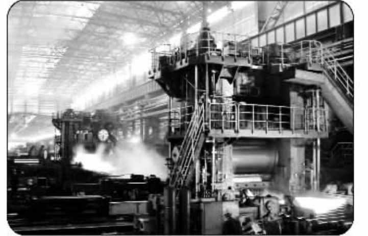
2013年，柳州冶金行业产值突破800亿元。柳钢加快向高端用钢领域迈进。图为柳钢生产线。
