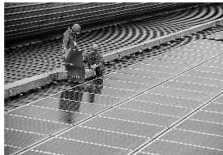
2月19日，浙江德清县供电公司工作人员检查已经并网的企业光伏屋顶。浙江省德清县临杭工业区天马重工机械有限公司厂区的屋顶光伏项目一期工程已于2014年初并网发电。目前该光伏工程一期面积20万平方米，共安装6.3万块光伏板，每年可发电1600万千瓦时。项目一期日平均发电量约5万千瓦时，最高每天可发电8万千瓦时，并网一个多月运行平稳，初现成效。 新华社记者 徐 昱 摄
