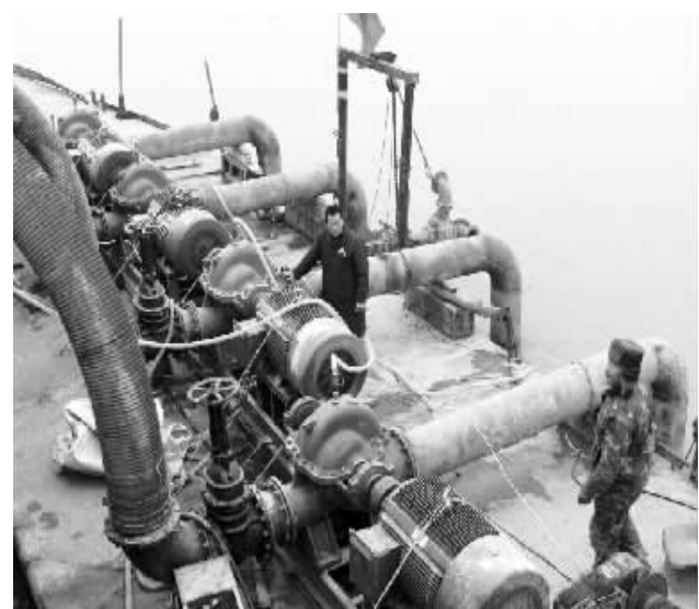
2月23日，工程人员在穿黄工程隧洞充水试验现场值守。穿黄工程是通过并排的两条隧洞把中线调水从黄河南岸输送到北岸，隧洞工程从水下40米处横穿黄河，单洞长达3450米，是南水北调中线工程中的控制性工程。 新华社记者 朱 祥摄
