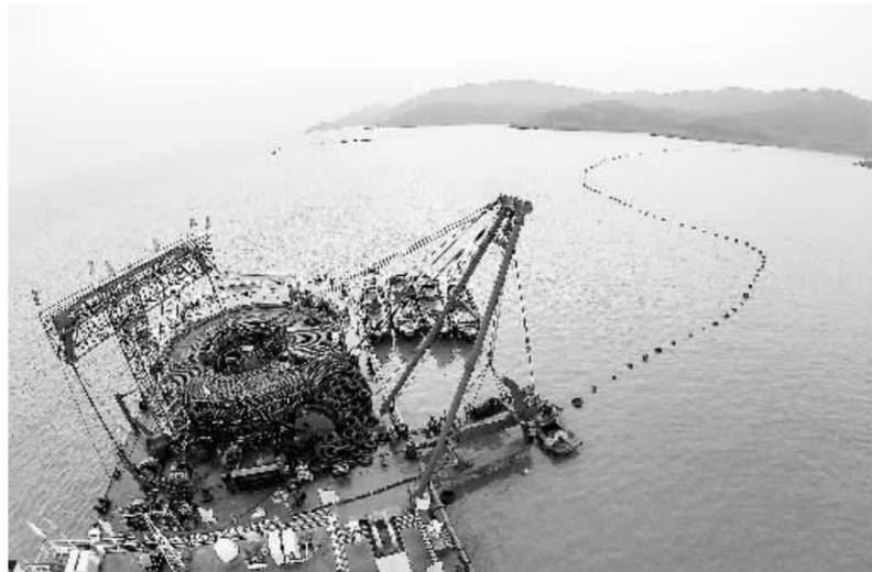
2月21日清晨,51公里长的海缆开始敷设入海。当日,51公里长的国产单极电压等级最高、长度最长的直流海缆在浙江舟山海域敷设入海,标志着世界首个五端柔性直流输电示范工程进入后期攻坚阶段。
