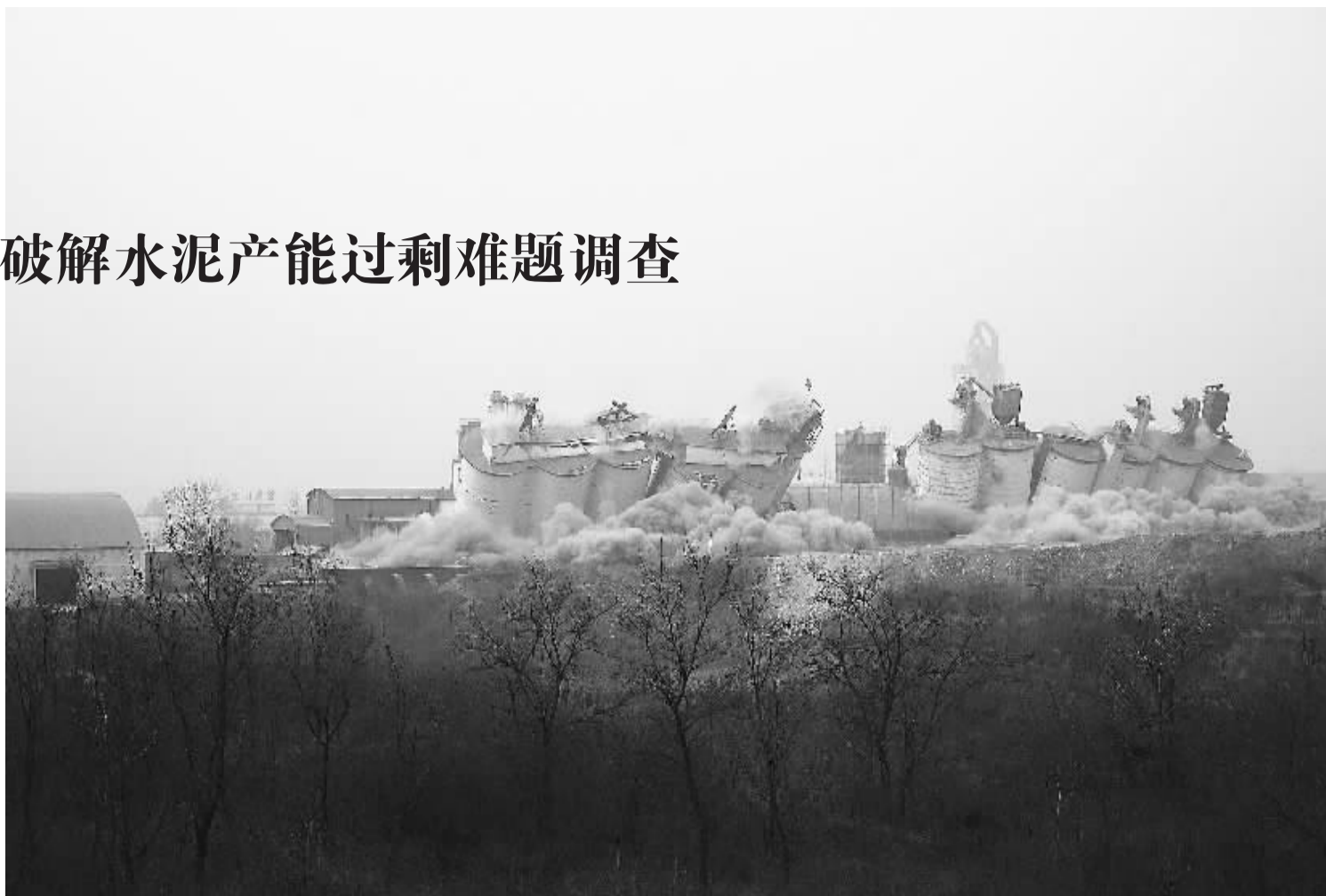
2月17日,石家庄第二次集中拆除水泥企业的第一爆破现场。
