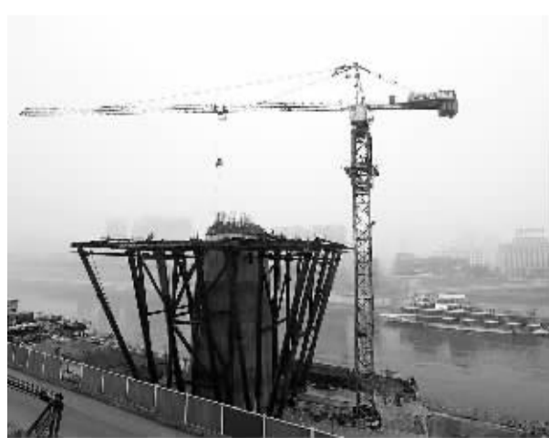
葛洲坝坝上公路替代用桥——宜昌庙嘴长江大桥在加紧建设，预计在2015年11月通车。图为建设现场。
