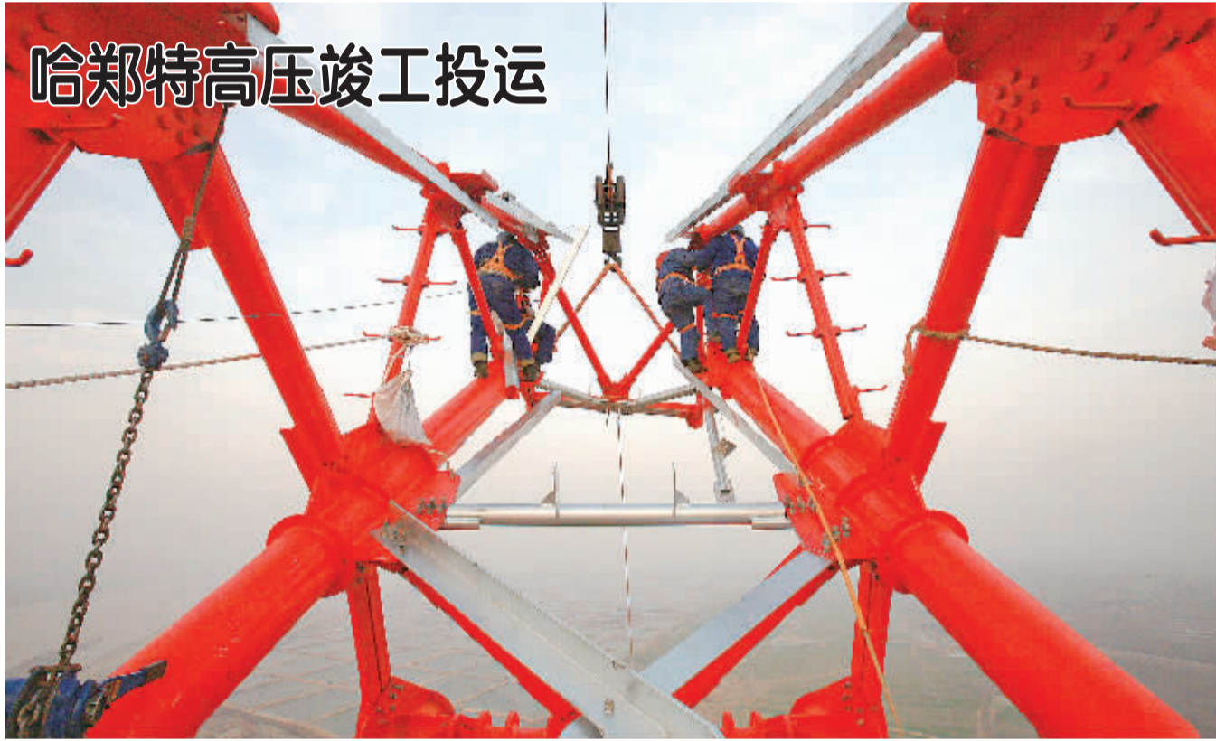
哈郑特高压工程跨黄河施工(资料图片)。
