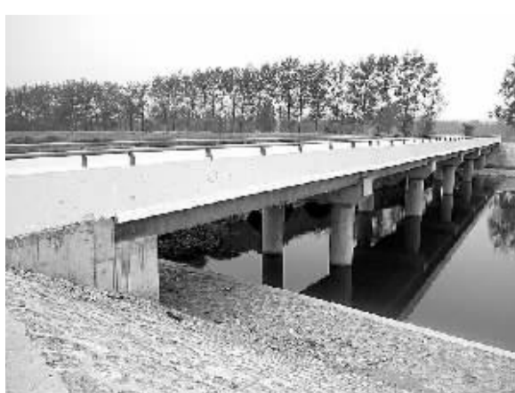
这是疏浚治理完工后的安徽宿州埇桥区欧河河道。入冬以来，宿州埇桥区积极开展农田水利提升工程和重点工程建设，欧河治理工程完工后，除了发挥灌溉功能，还可应对20年一遇的洪水。 王武奎摄
