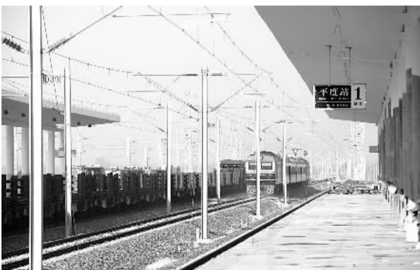
图为海青铁路平度站。
