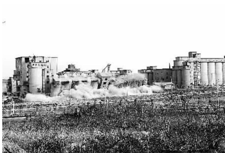
安徽淮南市大通区日前对淮南巨石水泥有限公司进行分步骤定向爆破拆除。陈彬摄
