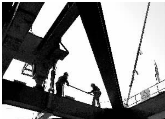
1月1日,工人在高空建设湖北恩施高速建河特大桥。恩施高速是国家高速公路陕西安康至湖南吉首高速的组成部分,预计2014年秋建成通车。宋文摄(新华社发)
