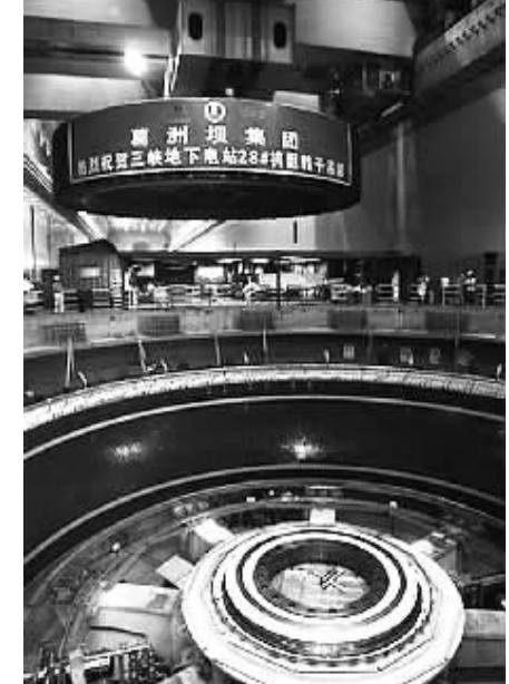
三峡蒸发冷却水轮机转子吊装。
