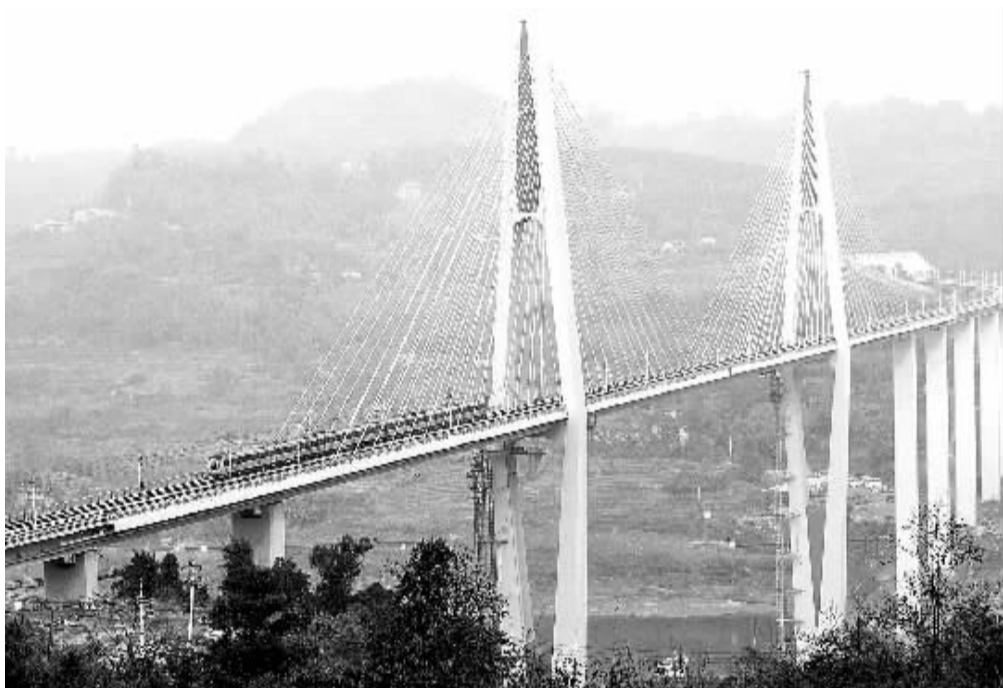
12月30日,一列地铁列车在重庆地铁6号线2期的世界第二大跨径的轨道交通专用斜拉桥——蔡家嘉陵江大桥上行驶。重庆地铁6号线2期12月31日开通运营,该地铁工程长约26.2公里,其中隧道22公里,高架线路4公里,横跨嘉陵江。该线路的开通将素有“重庆后花园”之称的北碚区纳入了重庆轨道交通线路网络;至此,包括渝中、江北在内的重庆主城区9大行政区全部实现轨道交通覆盖,重庆轨道交通通车里程达到170公里。新华社记者 刘潺摄
