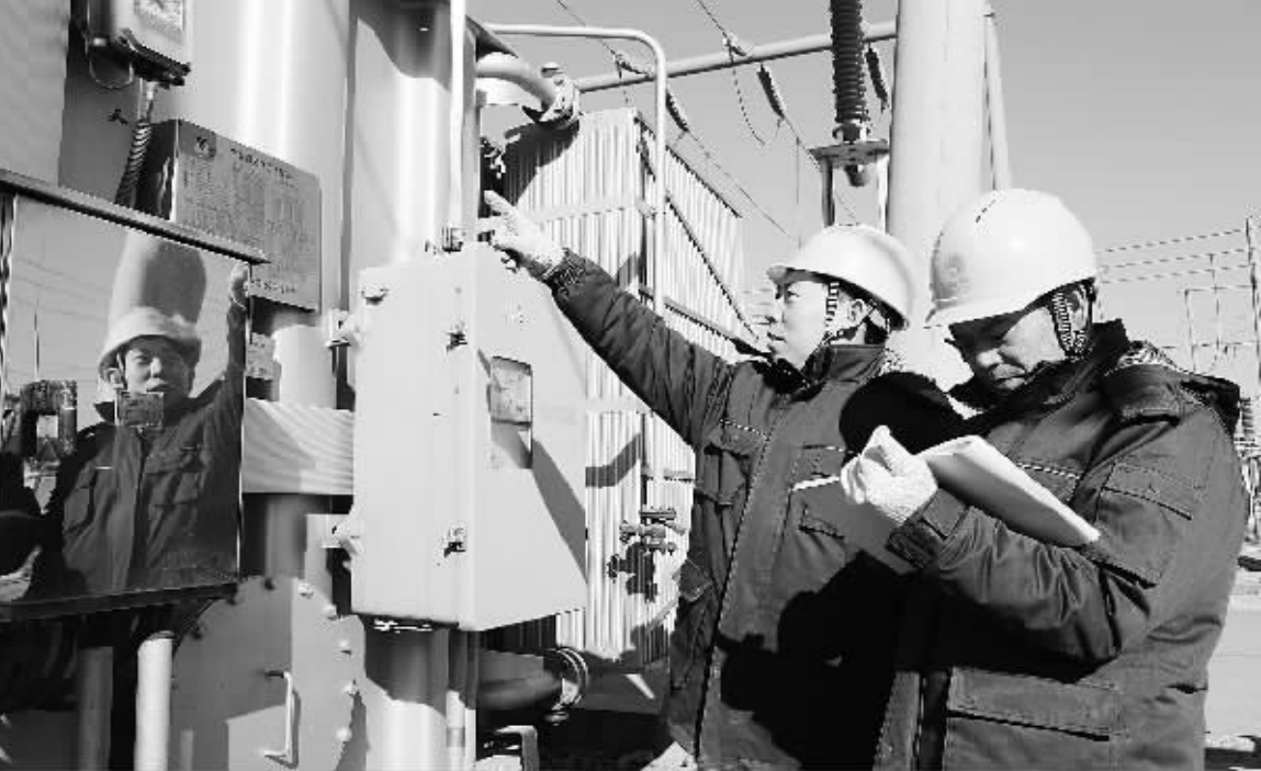
12月27日,国网沂水县供电公司运维检修人员在北郊110千伏变电站查看主变油温表盘。当日,国网山东沂水县供电公司所辖区内的25座变电站进行了详细巡视,确保电网安全稳定运行,迎接元旦的到来。
