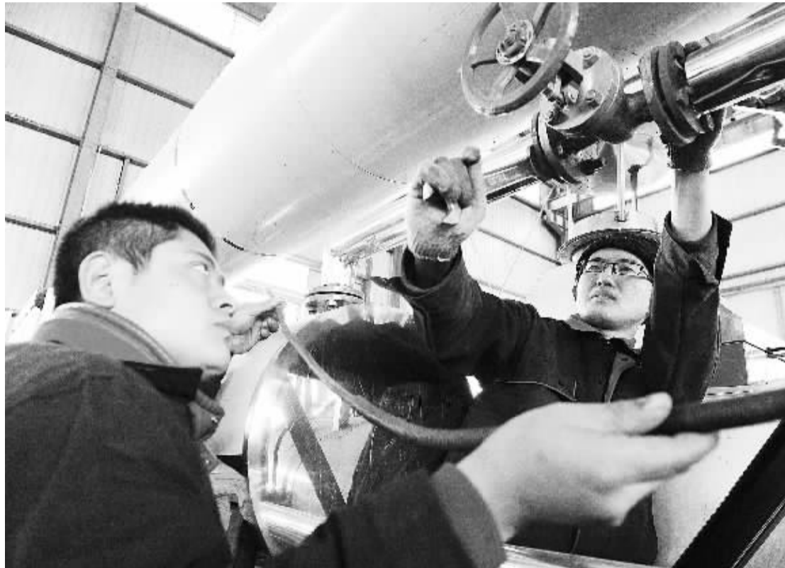
位于山东无棣县海丰街道的龙腾机械有限公司的员工正在安装饲料机械。该公司制造的机械产品在东南亚多个国家。
