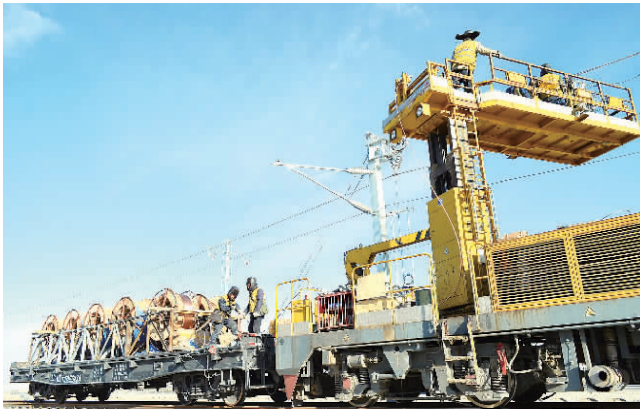
12月12日, 兰州铁路局嘉峪关供电段组织施工单位对嘉峪关至玉门段架设接触网。全长1776公里的兰新铁路第二双线, 设计时速超过200公里, 线路东起兰州, 西至乌鲁木齐, 构成新疆通往内地的第二条铁路运输大通道。据了解, 兰新第二双线建设施工目前进入工程收尾阶段, 预计将于明年8月份进行联调联试。 周东山摄(新华社发)
