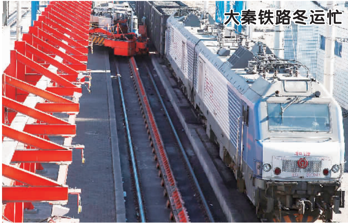
12月5日,在河北秦皇岛,一辆运煤专列驶入大秦铁路卸煤专用线。自10月1日进入冬季煤炭运输以来,我国西煤东运的主要通道大(同)秦(皇岛)铁路运输持续繁忙。
