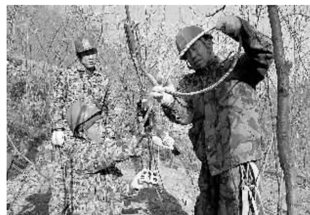
11月20日,电力工人在安装拉线。近日,荣乌高速涿源20标段供电专线架设进入攻坚阶段,国网河北涿源县供电公司施工人员翻山越岭,在太行山上架设10千伏供电线路,为荣乌高速公路建设提供电力保障。12月底,荣乌高速供电专线将全面竣工通电。 焦 斌摄(新华社发)
