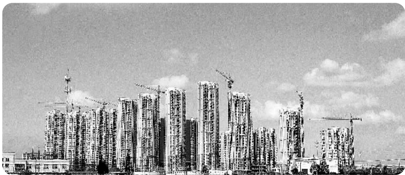
图为江苏南通一处正在施工的保障性安居工程。
