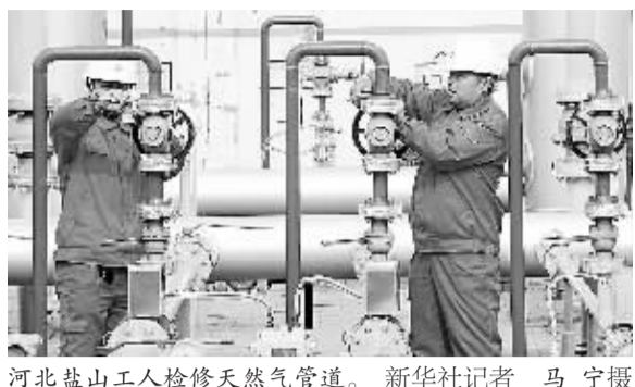
河北燕山工人检修天然气管道。 新华社记者 马宁摄
