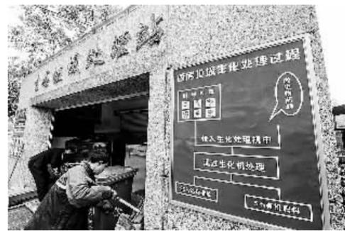
11月14日，工作人员拿出经过降解处理后的生态肥料。从11月初开始，杭州市西湖区西溪街道溪畔社区正式启用社区生态垃圾处理系统，这也是西湖区首个启用的社区生态垃圾处理系统。有机垃圾生化处理机24小时运行，每天可以处理厨房垃圾200公斤，通过微生物发酵分解，大部分转化为无害气体和水，剩下的变成生态肥料，免费提供给种植花木的小区业主。新华社记者 徐 昱摄
