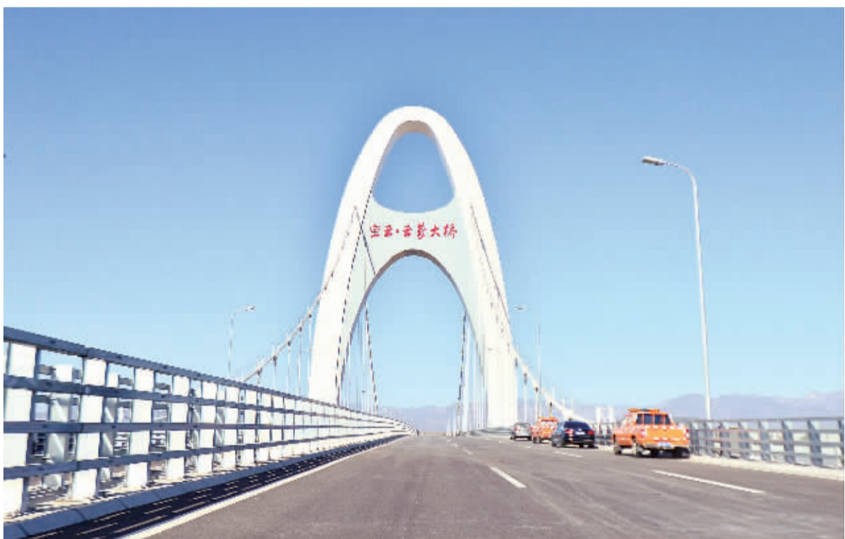
这是11月14日拍摄的北京密云云蒙大桥。当日,连接京承高速公路和密云经济开发区的密云云蒙大桥正式通车。这座大桥飞跨潮白河,全长744米,桥梁主塔外形采用“种子”造型,属单塔自锚式异型悬索桥。 吕 吉摄(新华社发)
