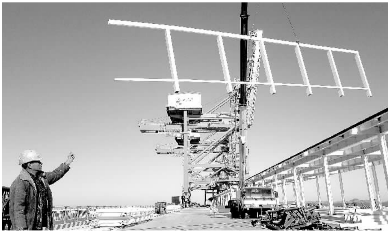
11月10日，工人在施工现场吊装传送装置的护栏。丹东港目前正在加紧建设30万吨级矿石专用码头，预计2013年底投入使用。该码头建成后将成为北黄海的第一座大型矿石码头，也是东北东部地区钢铁企业运输距离最近的大型矿石码头。新华社记者 王建华摄
