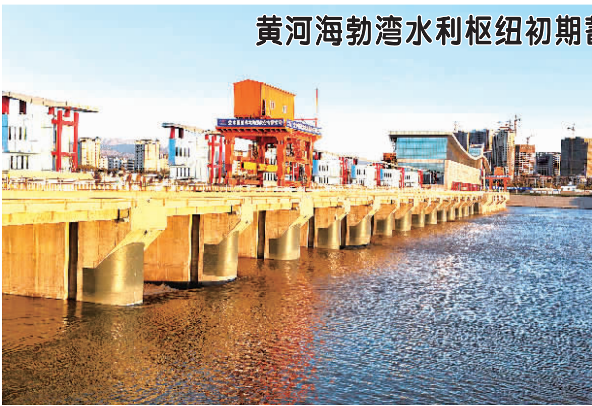
11月4日，黄河海勃湾水利枢纽工程已经完成初期蓄水。
