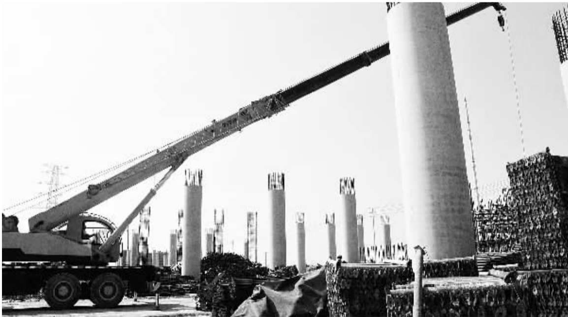
图为江苏省连云港市徐圩新区张圩互通项目现场。 本报记者 梁剑箫摄
