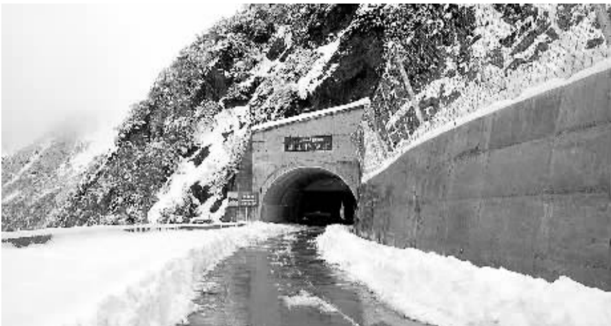
图为西藏墨脱公路控制性工程——嘎隆拉隧道，隧道全长3310米，坡度4.1%，是全国坡度最大的隧道。
