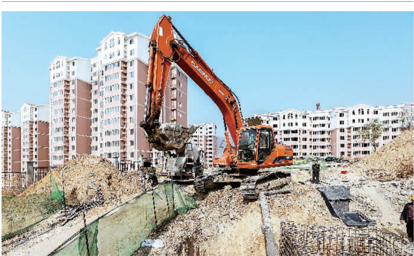
10月30日,在北京市门头沟区王平镇,工矿棚户区安置房的配套设施正在紧张施工。当日,位于王平镇的京煤集团工矿棚户区改造工程主体工程完工,居住在王平和大台两地棚户区的1612户居民将于2014年上半年迁入新居。 新华社记者 张宇摄
