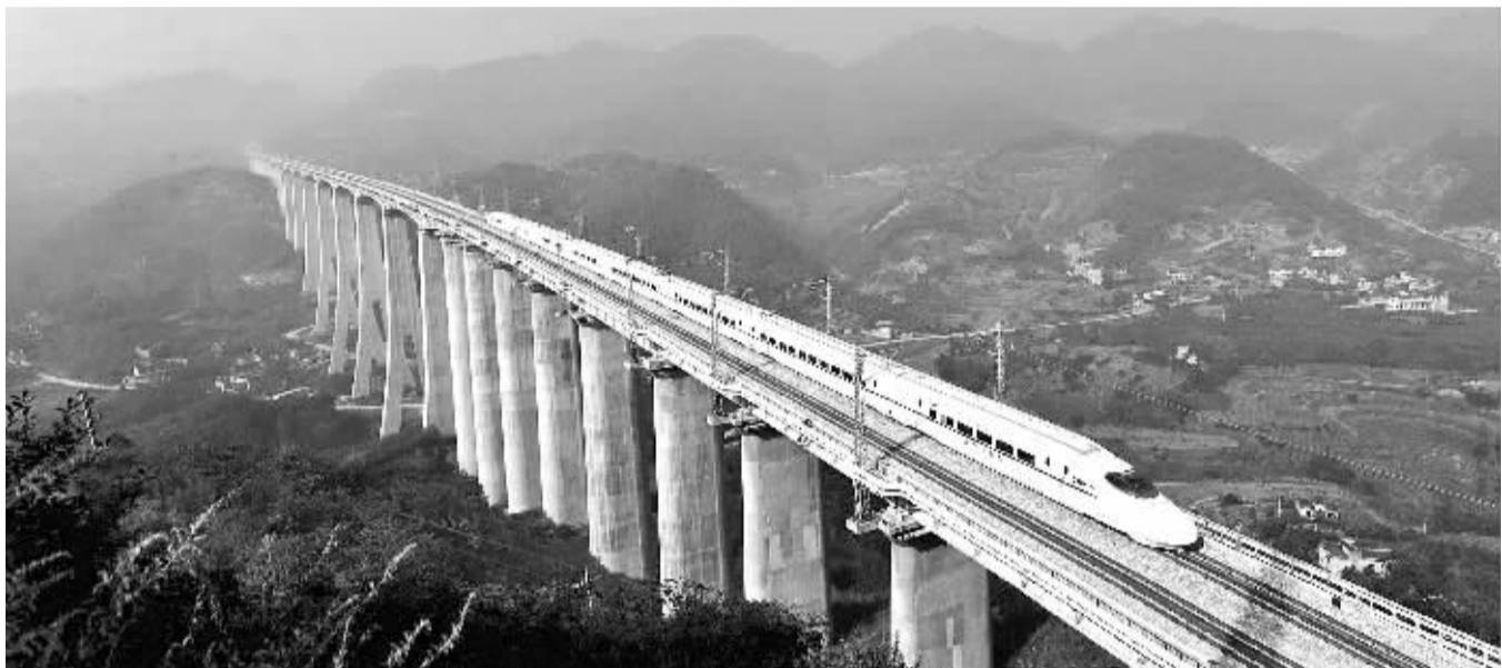
图为在渝利铁路联调联试中,动车组列车通过新桥特大桥。渝利铁路通车后将开行动车组和普通旅客列车,届时从成都、重庆到武汉、南京、上海等地的铁路出行时间将大大缩短。 曹宁摄(新华社发)
