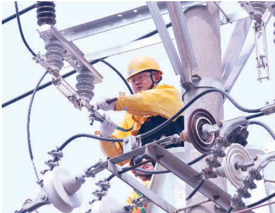
图为莆田供电公司工人正在带电作业。
