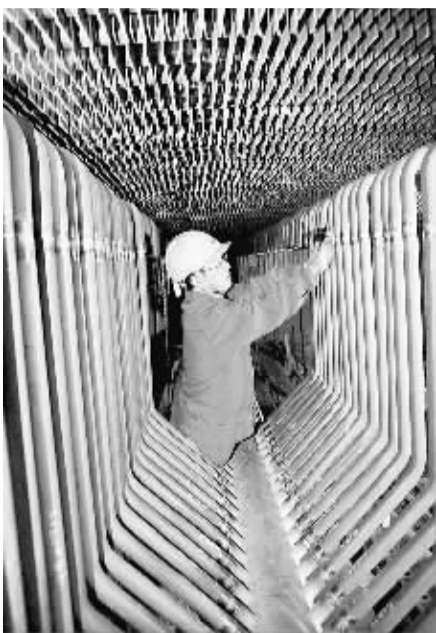
工作人员正在对设备进行维护。
