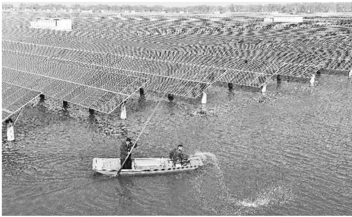
10月24日,工作人员在江苏盐城市建湖县的“渔光互补”光伏电站清洁水体。入秋以来,江苏盐城市建湖县1500亩水面上“渔光互补”光伏电站的水产养殖迎来丰收季,花鲢、白鲢、鲫鱼等混养的150亩水面生产的上市成鱼有近25600斤,沙塘鳢和河蟹混养的500亩水面亩产螃蟹预计超过120斤。
