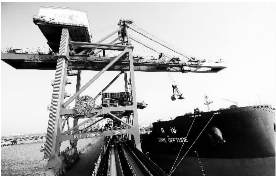
10月10日，河北唐山港曹妃甸港区矿石码头，桥式卸船机正在卸载铁粉。前8个月，唐山港曹妃甸港区吞吐量突破1.59亿吨，全年吞吐量预计突破2.4亿吨。据介绍，曹妃甸目前已建成煤炭、矿石、原油等生产性泊位47个，在建泊位28个，到2015年，曹妃甸港区将形成5亿吨吞吐能力。本报记者 赵晶摄
