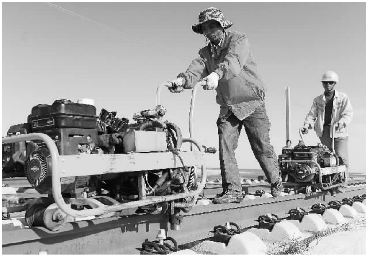
中铁十一局三公司的施工人员在兰新铁路客运专线甘(甘肃)青(青海)段对轨道进行精调(9月28日摄)。兰(兰州)新(新疆)客专是我国高寒高原风沙戈壁地区的第一条高速铁路。兰新客专从兰州西站引出，经青海省西宁、甘肃省张掖、直抵乌鲁木齐，计划2014年4月30日前竣工。
