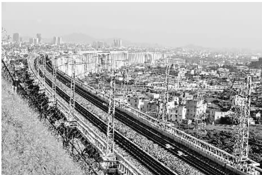
图为向莆铁路莆田特大桥。 张学东摄
