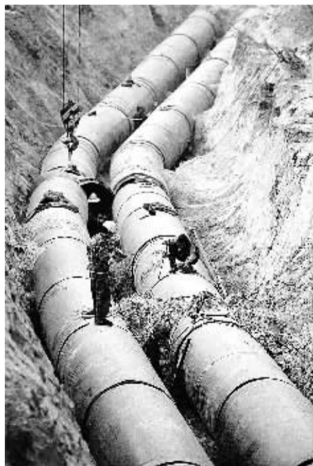
唐山大力实施集中供热工程,减少分散供热造成的大气污染。
