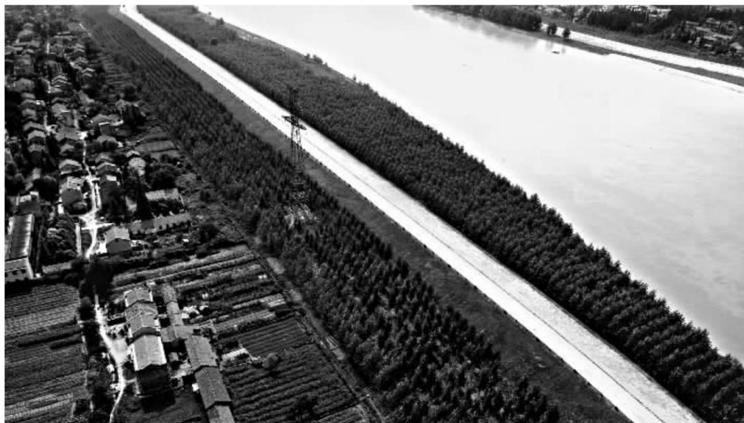
湖北洪湖市境内的135公里长江干堤两旁防护林防蚀固土，维护着堤坝安全。
