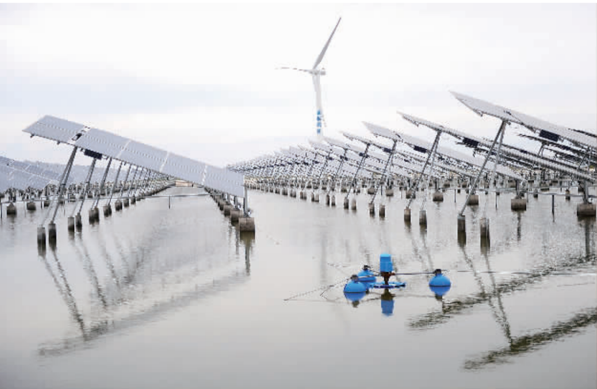
9月5日拍摄的江苏东台“风光渔”互补新能源基地。“风光渔”互补是指上有机电、中有光电、下有养殖的三层立体收益综合体。东台市充分利用沿海丰富的风、光资源,实行立体开发,建设“风光渔”一体化发电站,初步显现出生态效益和经济效益。 耿玉和摄(新华社发)
